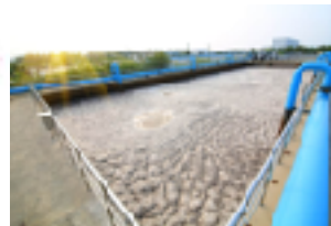
Fanghe di depurazione
